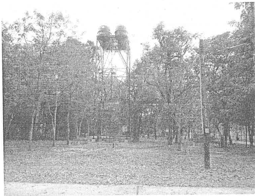
โครงการก่อสร้างระบบประปาพร้อมหอถังสูง บ้านโสกเชือก หมู่ที่ 7 (ในวัดโคกวนาราม)
