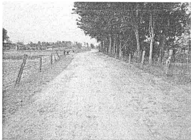
โครงการก่อสร้างถนนลูกรัง บ้านโพธิ์ชัย หมู่ที่ 4 (เส้นบ้านนางนวย รีผาดำ ไปถึงเนินสามแยกบ้านปอภาร)
