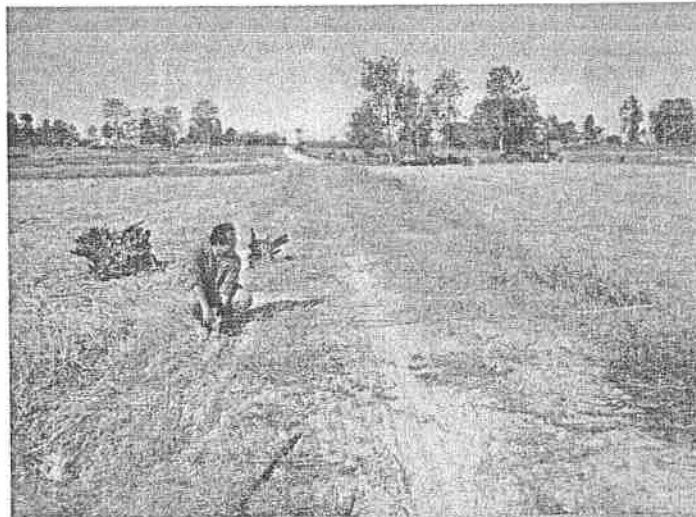
โครงการก่อสร้างถนนลูกรัง บ้านหนองแสง หมู่ที่ 3 (เส้นทางนายทองใบ ถึงไร่ค่าย พล.ร.6)
