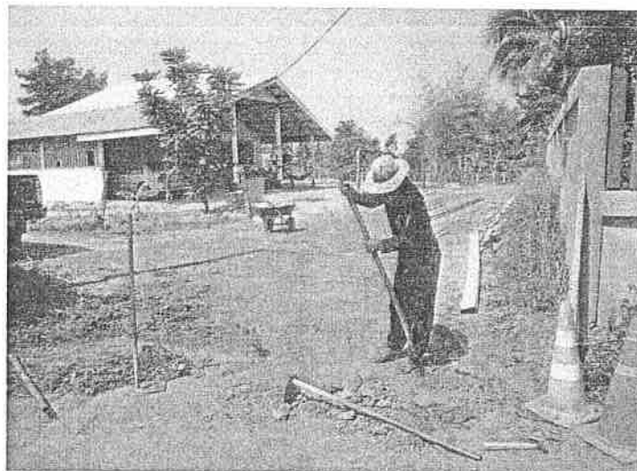
โครงการก่อสร้างถนน คสล. บ้านโพธิ์สัยน้อย หมู่ที่ 1 (บ้าน ร.ต.สนิท - บ้านนายทวี.คุ้มหนองงูเห่า)
