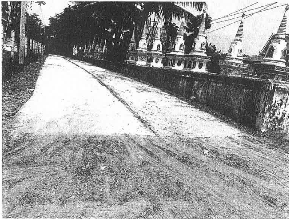
โครงการก่อสร้าง ถนน คสล.บ้านหนองแสง หมู่ที่ 3 (เส้นข้างวัด - ดอนปู้ตา) สัญญาจ้างเลขที่ 7/2562 ลงวันที่ 26 เมษายน 2562
